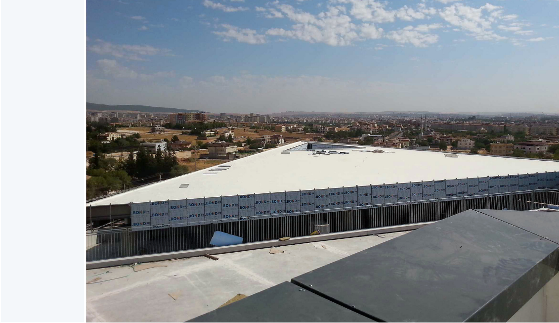
Tamamlanmış çatı yüzeyi
